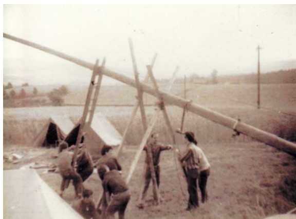
Obrázek 3. Stavba stožáru antény pro SEA.
