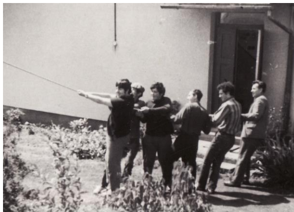
Obrázek 4. Stavba stožáru antény pro SEA.
