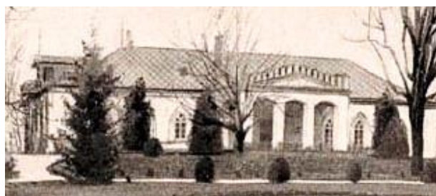
Obr. č.2: Bubnová kupola na severnom balkóne Konkolyho domu v Ógyalle.
