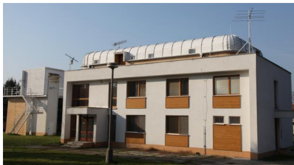
Obr. č.21: Budova HSFA v Hurbanove.
